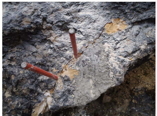
Tentative un peu gourmande, avec seulement 3 trous. La fissuration est fine, nette et profonde, merci les burins, ils ont bien travaillé.
