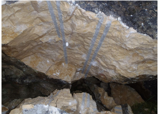
La flèche bleue indique un trou isolé, qui ne participe pas à la fissuration.
