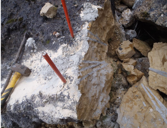
L'abattage de la deuxième ligne de fissuration.
